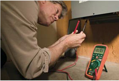
Aplicación CAT IV para medir el voltaje en un transformador trifásico de 480V.
