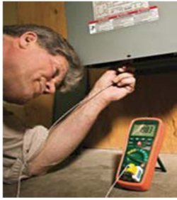
Medición de la temperatura interna en la instalación de un transformador trifásico.
