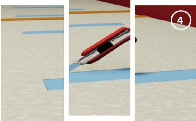
4.- Ya colocado el bajo alfombra (poliafoam) trace los recuadros con un marcador en donde irán puestas las celdas, y proceda a cortar con un cúter dicho recuadro. Según el cálculo obtenido (como se explica en el paso 1) ponga las celdas repartidas entre un rango de 50cm a 100cm de separación entre celda y celda. **NOTA:** Procure no poner celdas donde ya sabe que habrá libreros, camas, o muebles que eviten que el calor salga y se quede atrapado debajo de los muebles.
