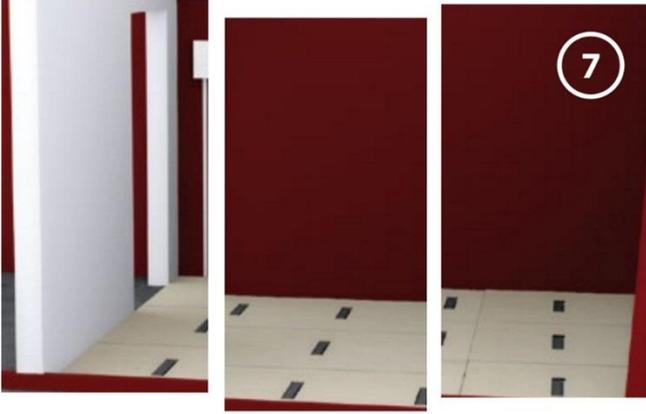
7.- Coloque en el piso las placas de MDF que ya contienen los recuadros cortados y pegue las uniones con cinta adhesiva. Las placas de MDF no deben quedar encimadas una de la otra ni con espacios entre ellas.
