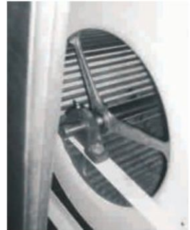
Turbina tipo aspas adelantadas de construcción reforzada industrial.
