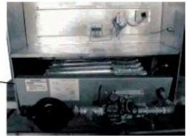
Kit de quemadores de fácil acceso y desmontable
