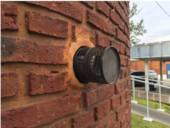
El Calefactor a Gas de Tiro Balanceado, BluxFlame requiere un hueco en el muro a instalarse, ya que toman el aire del exterior, realizan la combustión y vuelven a enviar los gases quemados al exterior. Estos Calefactores son los recomendables para uso en cualquier área.
